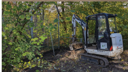
Der Bagger ist bereit zum Einsatz!
