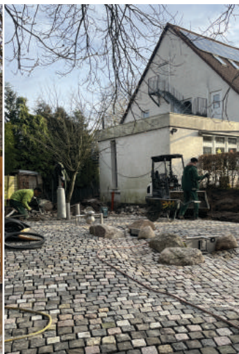
Das Pumpe für das Wasserspiel ist schon installiert!
