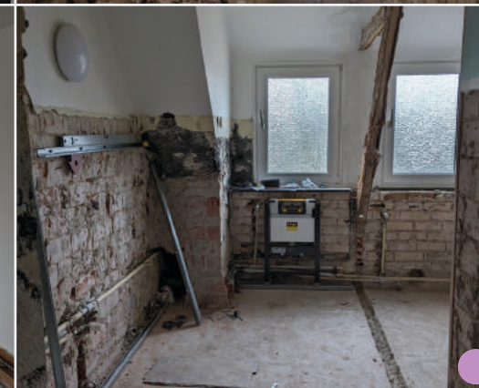
Aus einzelnen Toiletten entsteht ein neuer Waschraum mit Dusche und Wickeltisch
